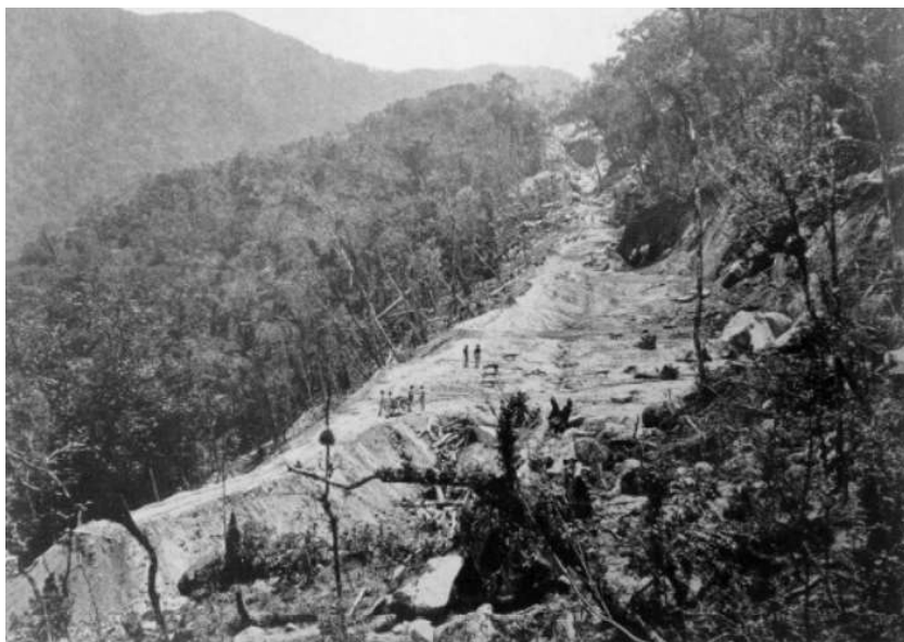
Imagem 2: Preparação do terreno para instalação da Via Férrea. Fonte: Arquivo RFFSA / In Lavander Junior; Mendes, (2005) apud Passos (2024).
