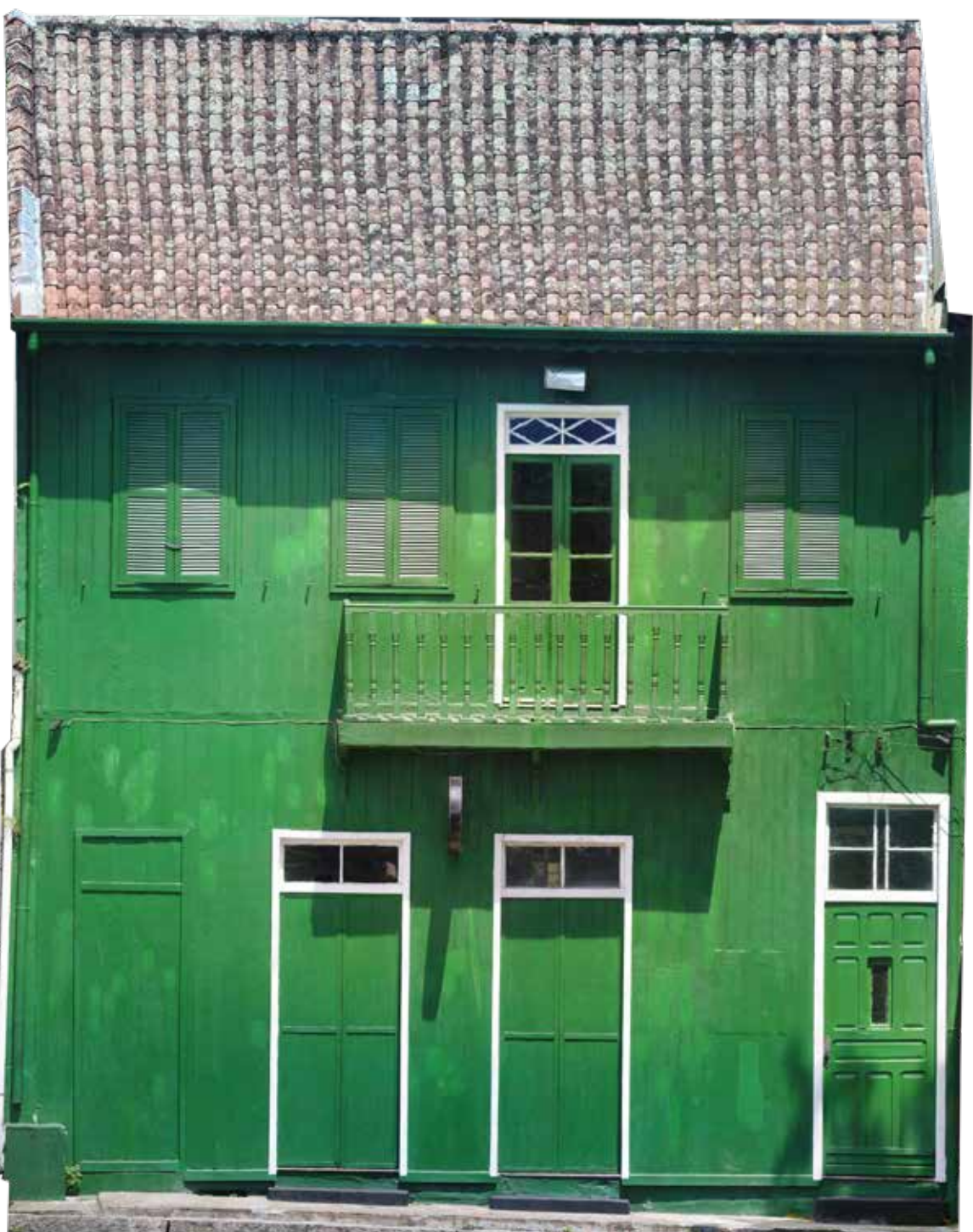
IMAGEM 018 • TIPOLOGIA ACUPAÇÃO DA PARTE ALTA • SISTEMAS CONSTRUTIVOS DISTINTOS: MADEIRA. • ORTOFOTOS: MAPPEAR ENGENHARIA
