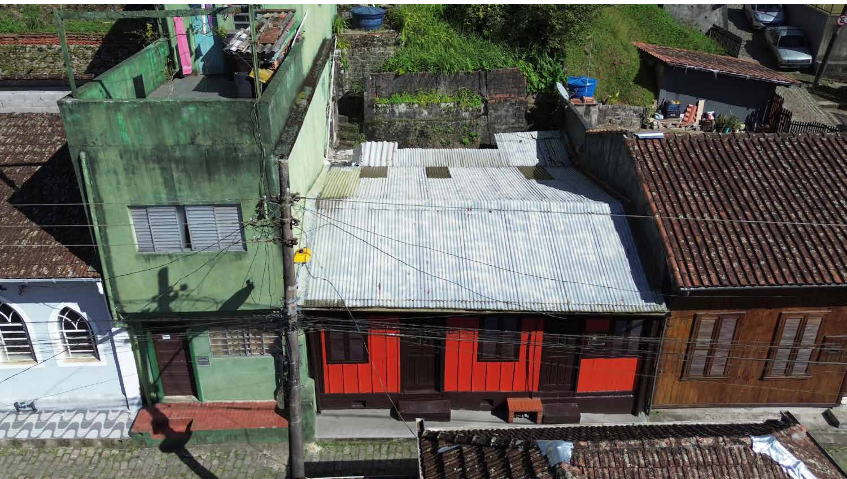
IMAGEM 025 • EXEMPLO DE TELHAS DE FIBROCIMENTO • FERNANDA FIGUEIREDO D'AGOSTINI
