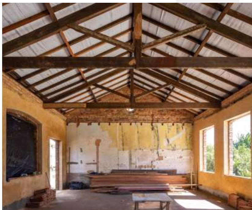
Foto 8: Arquivo Leo Giantomasi – Cobertura restaurada e subcobertura
