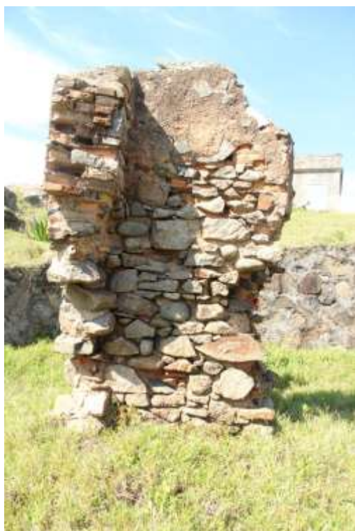
Foto 1: Alvenaria predominantemente de pedra
