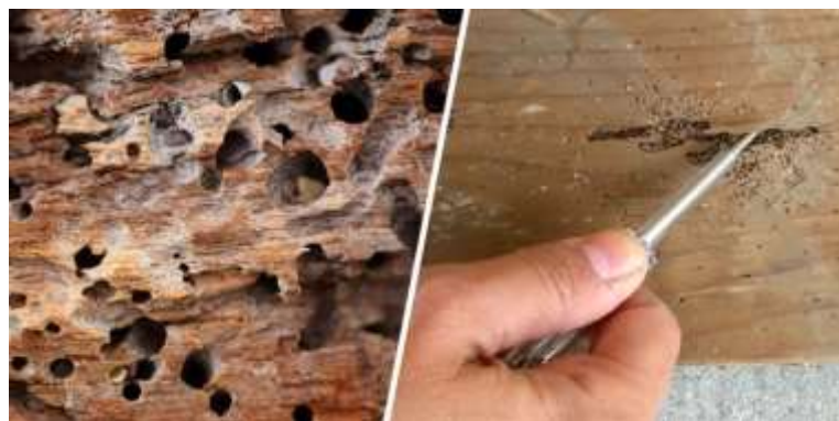
Foto 7: Madeira atacada por cupins
