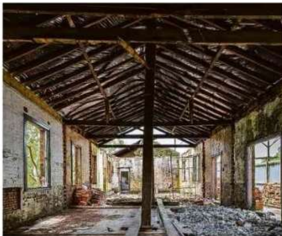
Parte interna da estação Campo Grande, na vila ferroviária de Paranapiacaba, que passa por restauro
