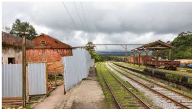
A estação ferroviária de Campo Grande, inaugurada em 1889, começou a ser restaurada na Vila de Paranapiacaba, em Santo André, região metropolitana de São Paulo. Foto: Leo Giancomasi
