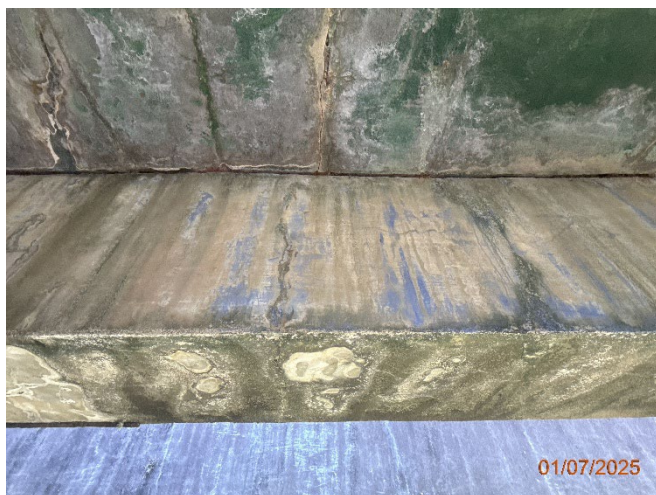
Foto 18 – Fissura vertical de flexão passante a viga.
