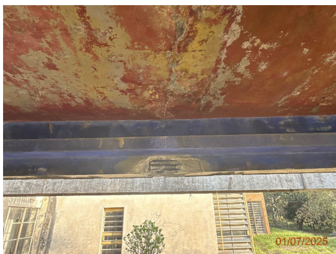
Foto 56 – Armadura exposta e corroída com redução de seção.
