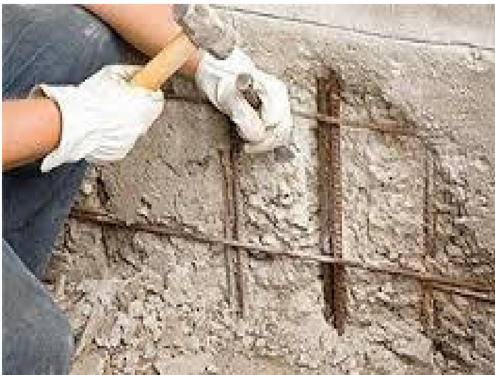
Figura 15 – Ilustração do procedimento de escarificação do concreto nas áreas a serem tratadas. Fonte: O Autor.
