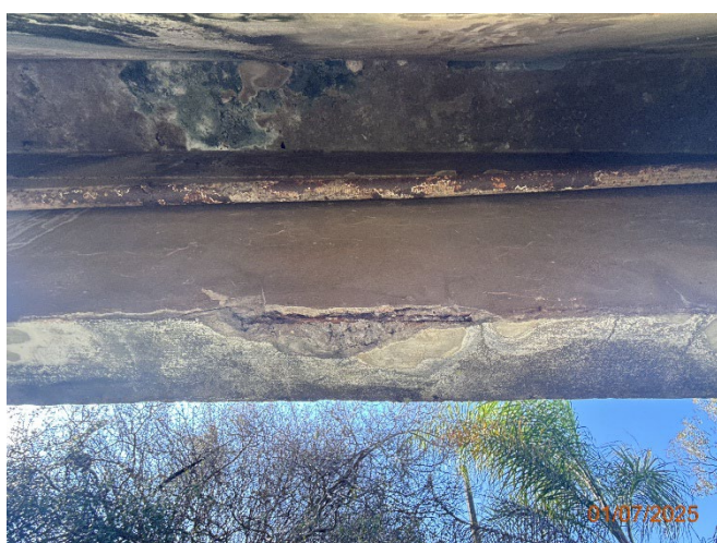
Foto 10 – Armadura exposta e corroída com redução de seção.
