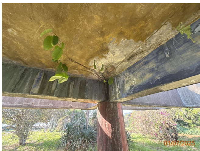
Foto 40 – Fissura com percolação de água e eflorescências.
