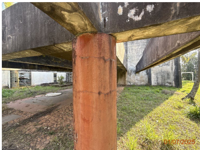
Foto 38 – Fissura com percolação de água e eflorescências.
