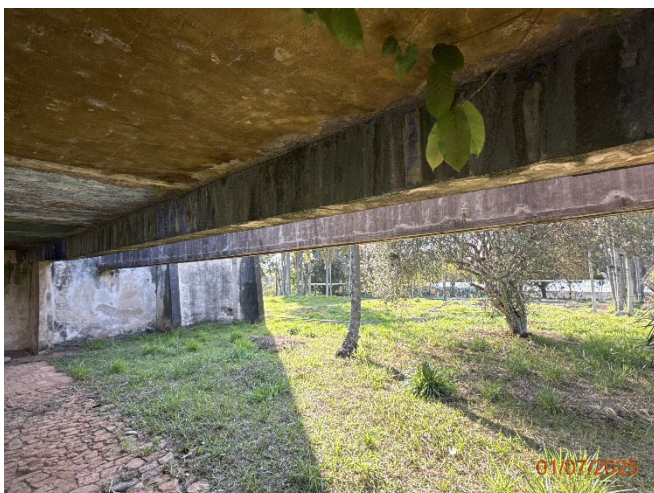
Foto 24 – Fissuras e percolação de água através das vigas e lajes.
