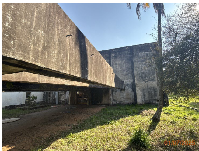
Foto 9 – Impregnação generalizada de fuligem sobre as superfícies de concreto.
