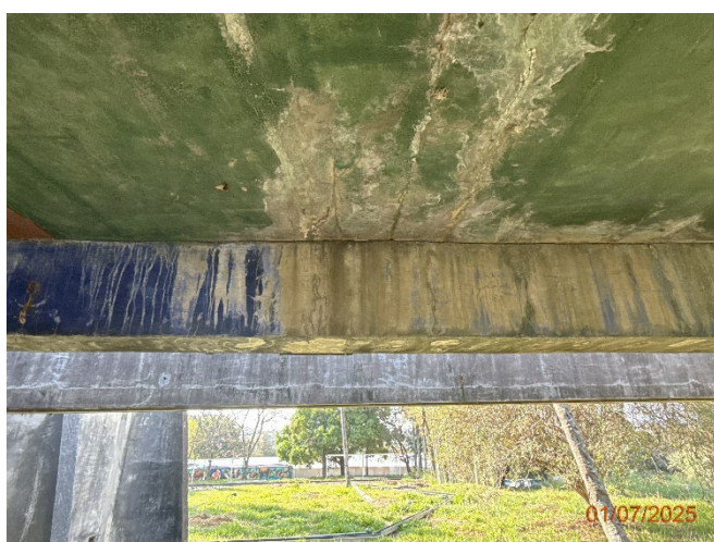
Foto 16 – Fissuras e percolação de água através das vigas e lajes.
