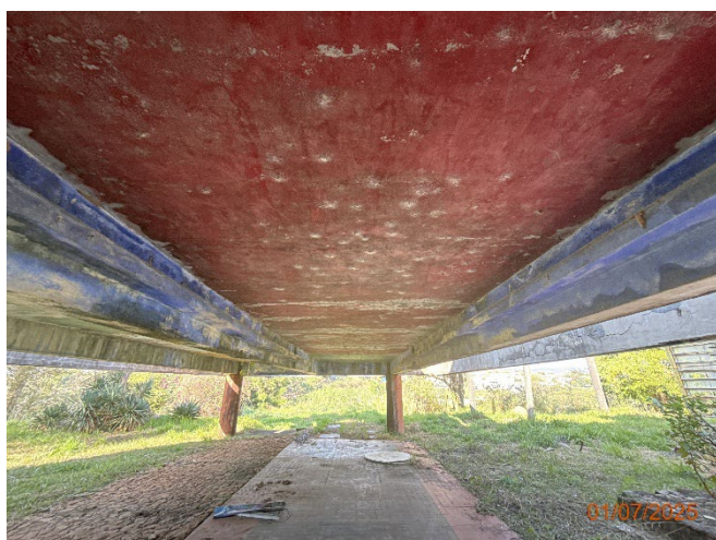
Foto 34 – Fissuras e percolação de água através das vigas e lajes.
