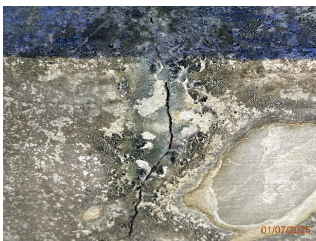
Foto 23 – Vista aproximada da foto anterior. Constatase abertura superior a 1,0 mm.
