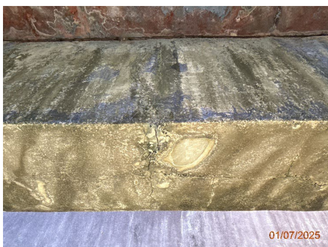
Foto 22 – Fissura vertical de flexão passante a viga.
