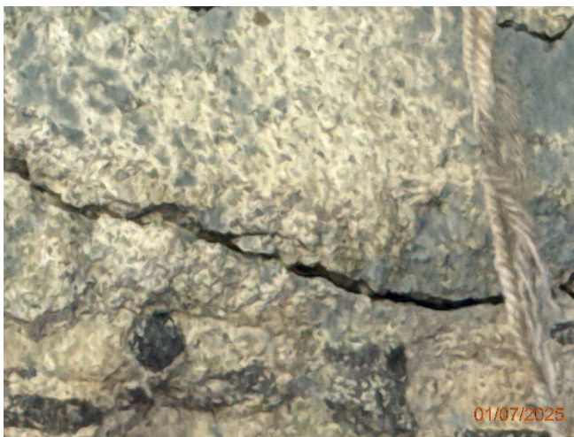
Foto 45 – Constata-se fissura indicando área de degradação elevada do concreto e do aço.
