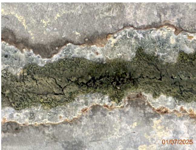
Foto 37 – Fissura com percolação de água e eflorescências.
