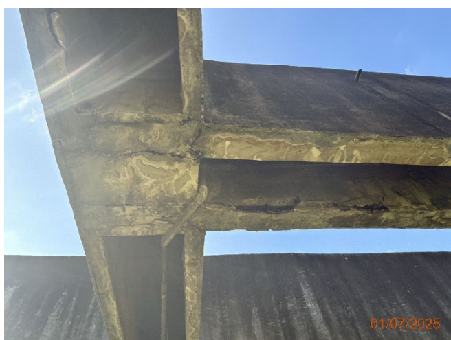
Foto 52 – Armadura exposta e corroída com redução de seção.
