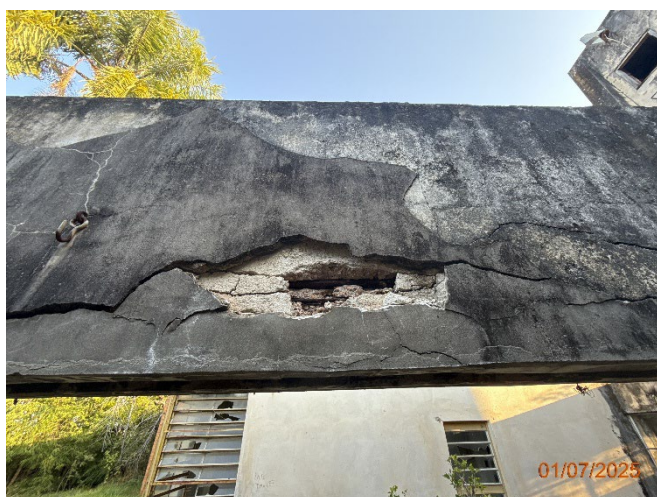
Foto 32 – Armadura exposta e corroída.
