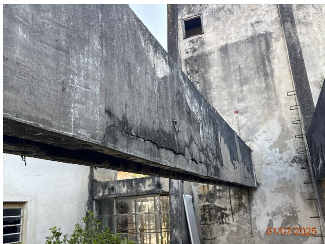
Foto 30 – Armadura exposta e corroída.
