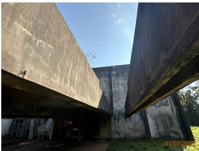
Foto 25 – Fissuras e percolação de água através das vigas e lajes.
