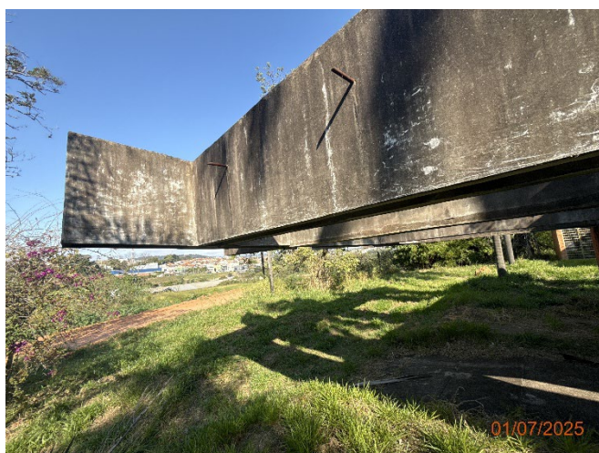
Foto 8 – Impregnação generalizada de fuligem sobre as superfícies de concreto.
