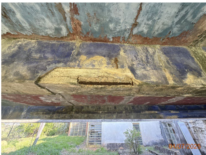
Foto 42 – Armadura exposta e corroída com severidade no processo.
