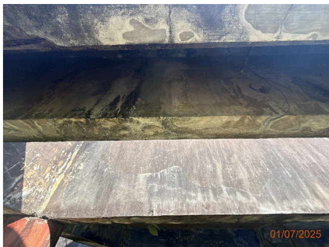
Foto 12 – Fissuras e percolação de água na face inferior da viga-calha.
