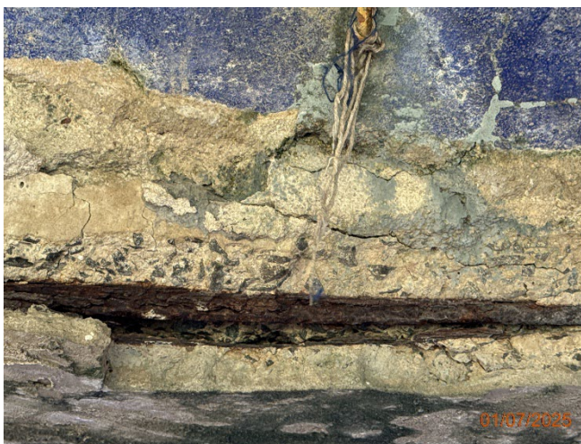
Foto 43 – Constata-se redução de seção e fissuras no concreto.
