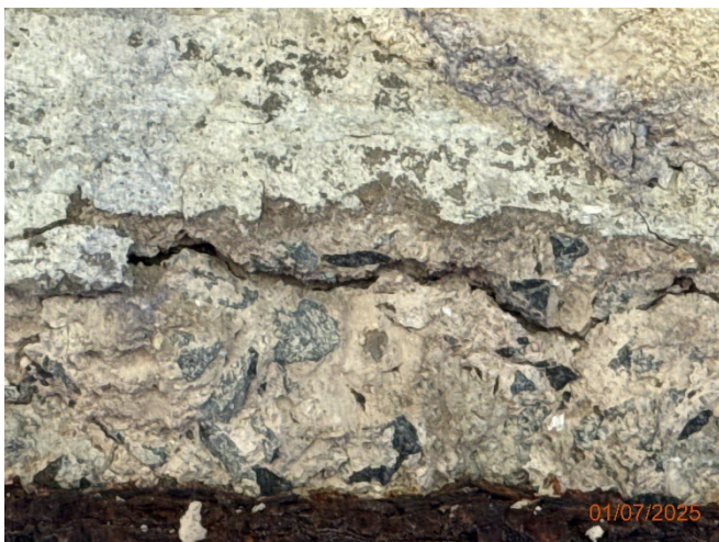
Foto 44 – Constata-se fissura indicando área de degradação elevada do concreto e do aço.
