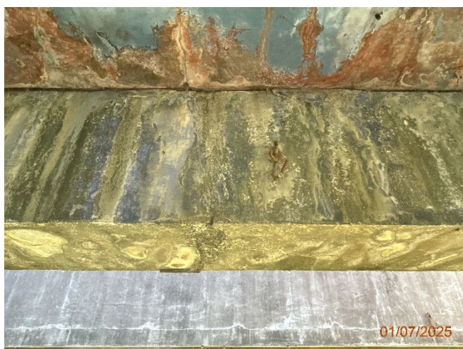
Foto 20 – Fissura vertical de flexão passante a viga.
