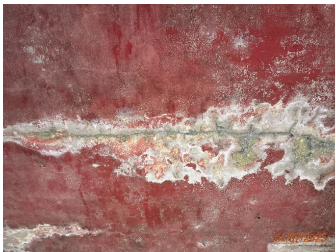
Foto 36 – Fissura com percolação de água e eflorescências.
