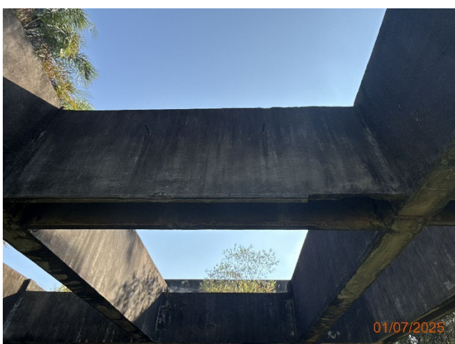
Foto 28 – Armadura exposta e corroída.
