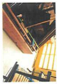
CONTRA PISO EM CONCRETO
