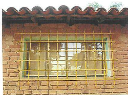
J2 e J3: Janela tipo basculante da S3
