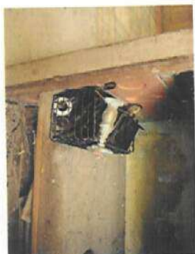
FECHADURA EM DEPOSITO DA FAZENDA
