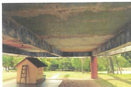
VARANDA LATERAL DIREITA OESTE
