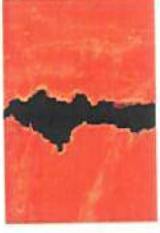
FORRO DE GESSO
