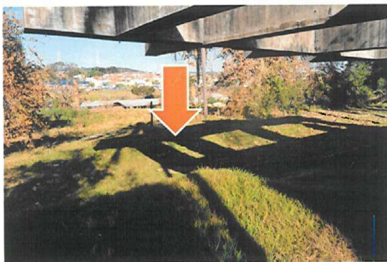
LOCAL DO ACESSO SECUNDÁRIO.
