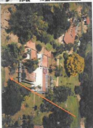
LOCAL DO ACESSO SECUNDÁRIO.
