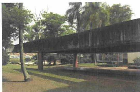
VARANDA LATERAL ESQUERDA LESTE
