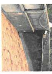
SUJIDADES E DESPRENDIMENTO DE ARGAMASSA PLATIBANDA DO SALÃO
