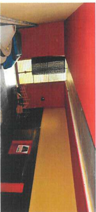
Foto do Salão eixos a morte de Flávio de Carvalho onde observa-se o comprometimento do rebuque de gesso em função das infiltrações de AP. Foto Ricardo Leite.
