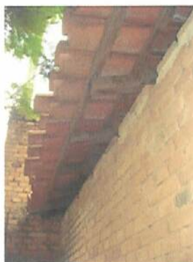
Beiral do telhado da S3.
