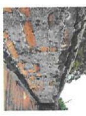
SUJIDADES E DESPRENDIMENTO DE ARGAMASSA PLATIBANDA DO SALÃO
