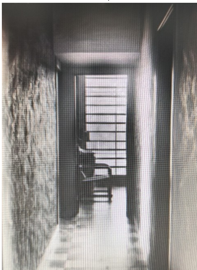
Imagem 2. Casa Sede da Fazenda Capuava, 1938. Acervo: Cedae – Centro de Documentação Cultural Alexandre Eulálio da Unicamp. Vista interna do corredor estreito, de paredes revestidas com argamassa ondulada e rugosa no reboco e pintura, evocando a atmosfera labiríntica de catacumbas ou túmulos faraônicos. Nota-se piso em taco de madeira com paginação dama.
