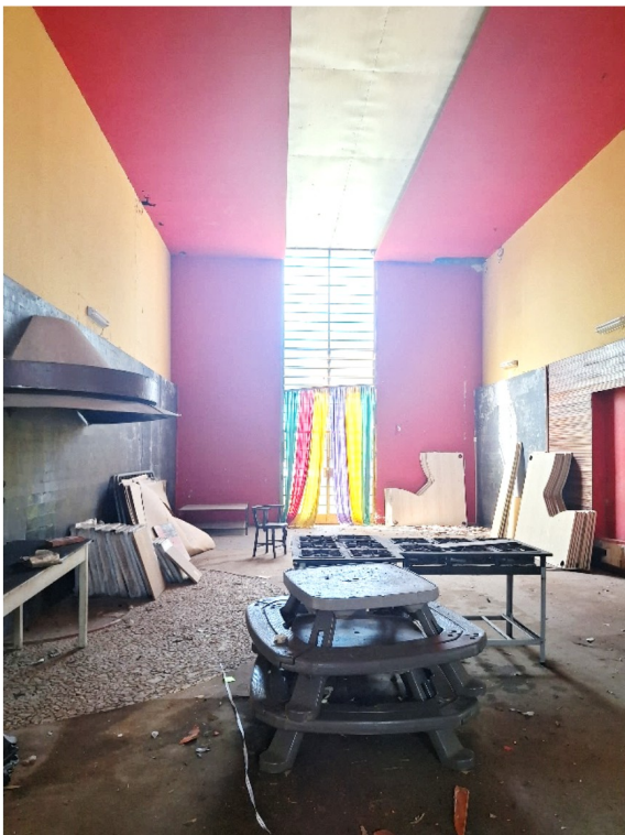
Imagem 20. Casa sede da Fazenda Capuava, 2025. Acervo: Brasil Restauro®. Vista interna do salão principal, com perda dos revestimentos do piso (taco de madeira), parede (tábua de madeira) e forro (gesso).
