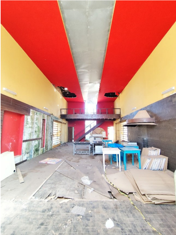
Imagem 16. Casa sede da Fazenda Capuava, 2025. Acervo: Brasil Restauro®. Vista interna do salão principal, com perda dos revestimentos do piso (taco de madeira), parede (tábua de madeira) e forro (gesso).
