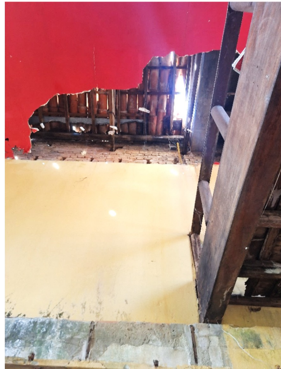
Imagem 17. Casa sede da Fazenda Capuava, 2025. Acervo: Brasil Restauro®. Perda e deslocamento de telha colonial. Deterioração dos materiais de revestimento do forro e parede, bem como do assoalho do mezanino.
