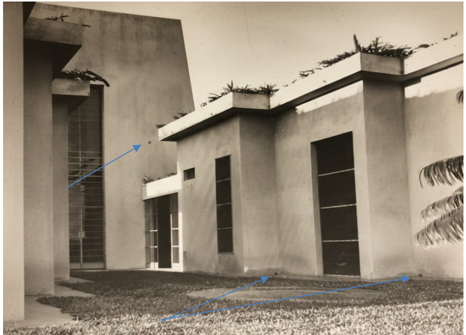
Imagem 4. Casa Sede da Fazenda Capuava, elevação posterior, 1938. Acervo: Cedae – Centro de Documentação Cultural Alexandre Eulálio da Unicamp. Vemos nesta imagem os drenos das floreiras, bem como todo sistema de captação pluvial embutido, indicado com seta.
