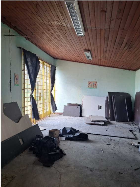
Imagem 26. Casa sede da Fazenda Capuava, 2025. Acervo: Brasil Restauro®. Living/biblioteca ilustrada na imagem 12 (ambiente 14, 1942), sem o forro original e sem o piso em taco de madeira com paginação em espinha de peixe.
