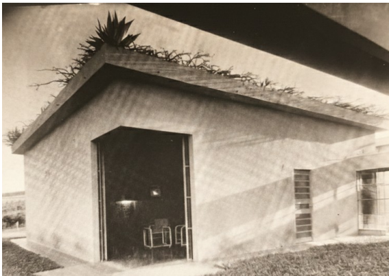
Imagem 4. Casa Sede da Fazenda Capuava, elevação posterior, 1938. Acervo: Cedae – Centro de Documentação Cultural Alexandre Eulálio da Unicamp. Vemos nesta imagem os drenos das floreiras, bem como todo sistema de captação pluvial embutido, indicado com seta.
